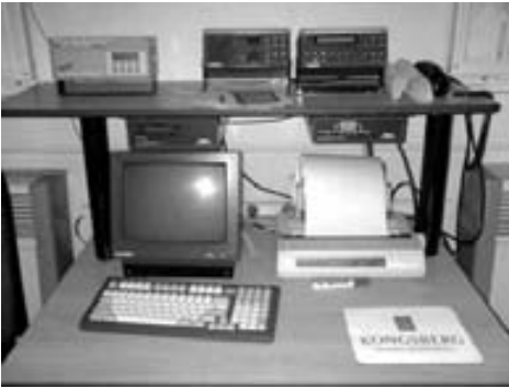
Foto oben: NAVTEX und VHF-Radio mit DSC-Controller; unten: INMARSAT-C Anlage mit Drucker.
