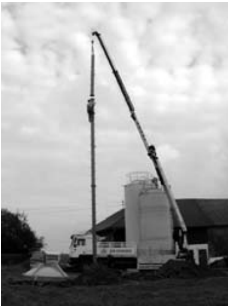
OE5VRL beim Mastaufstellen
